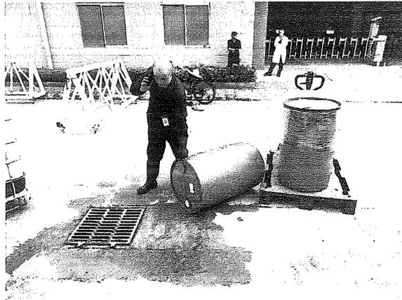
环境组主管赶赴现场检查实际情况，确认无其他药水混合污染后，启动针对性应急预案，安排环境应急人员穿戴好安全防护用品，首先将倾倒的废金水桶搬立起来，同时对被污染的雨水井检查口的管道进行封堵，使用应急吸收棉对路面上的泄漏废液进行围堵，围堵后将路面上的积存废液和雨水沟检查口管道内的全部废液用应急泵抽到应急吨桶内；
