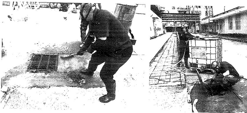
环境组应急人员对被污染的路面和雨水井检查口的管道完成最后1次清洗后，环境组主管通知化验室分析人员来雨水井检查口取样分析废水中氰含量，待分析确定清洗废水分析结果符合要求后，再安排人员进行现场解封，恢复雨水管道正常排放。处理完成后，应急桶里的废液以及吸收废液后的应急吸收棉，一并交由银辉公司进行收运处理。
