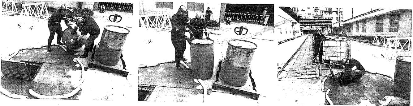
环境组应急人员将路面泄漏的积存废液、雨水井内的废液及围堵的应急棉清理干净后，使用足量的次氯酸钠药水，对被污染的地面和雨水沟管道进行循环清洗3次，清洗后的废水也使用应急泵清理到应急吨桶内；
