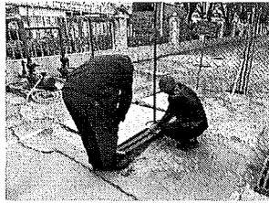
开启雨水井出水阀门，关闭应急泵
