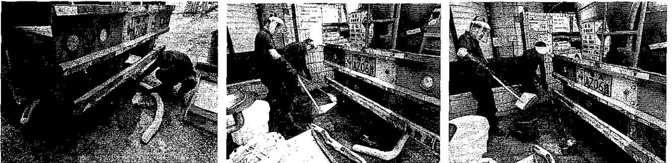
环境组应急人员对泄漏的废液进行清理后，使用自来水及清洁工具对马路地面进行清洁，并将清洁后收集的含铜废水通过围堰内应急收集泵回贮罐内，再抽到危废车辆；处理完成后，吸收废液后的应急棉则转移到危险废物仓库暂存，另作处理。同时，将蚀刻废液贮罐的废液抽空后，安排维修人员修复球阀。
