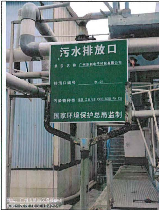
污水排放口 水-01 标志牌
