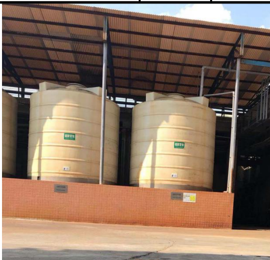
储罐及地面防护情况
